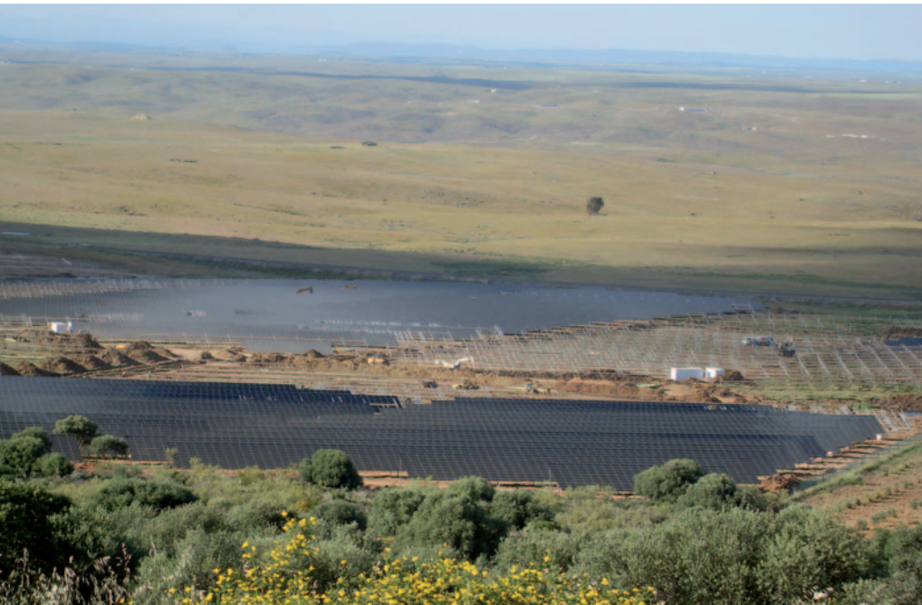
Das größte Freiflächen-Solkraftwerk Spaniens in Badajoz nahe der portugiesischen Grenze.
